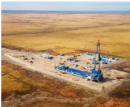
Монтаж буровой установки на скважине № 1700 куста газовых скважин № 17
