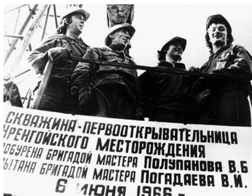
Бригада В. Полупанова у разведочной скважины P-2, 1966 г. (фото: urengoy-dobycha.gazprom.ru)
