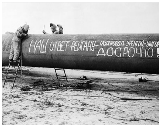
Строительство газопровода Уренгой – Помары – Ужгород, 1983 г. (фото: urengoy-dobycha.gazprom.ru)
