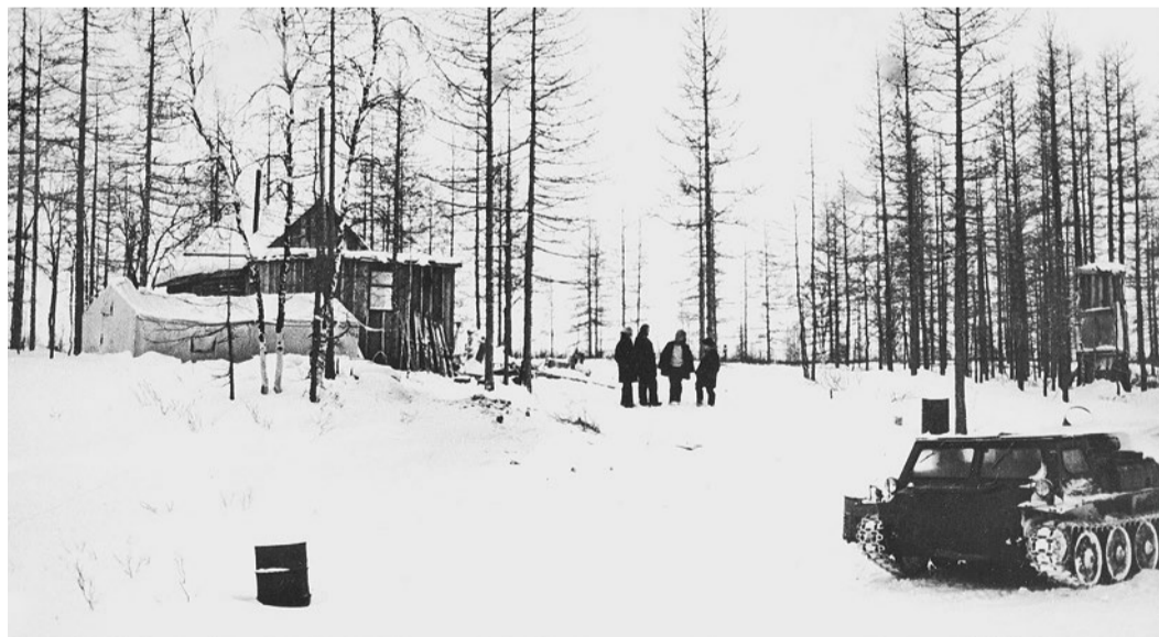
Сейсморазведочный отряд на правом берегу реки Пур, 1964 г. (фото: urengoy-dobycha.gazprom.ru)
