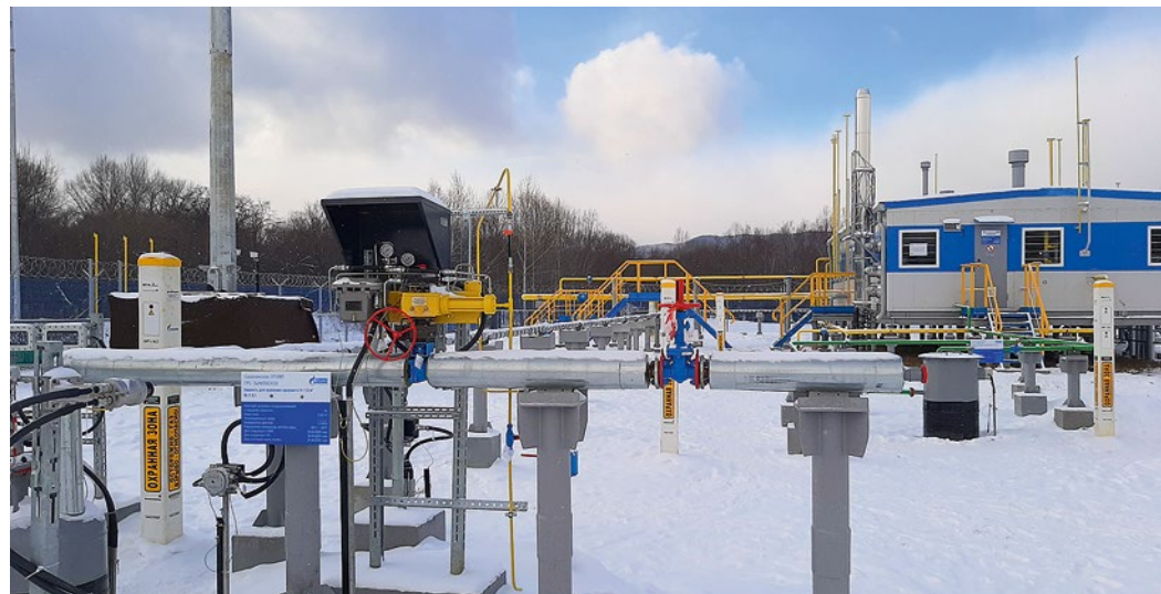
Объект «Газопровод-отвод и ГРС «Тымовское» Сахалинской области
