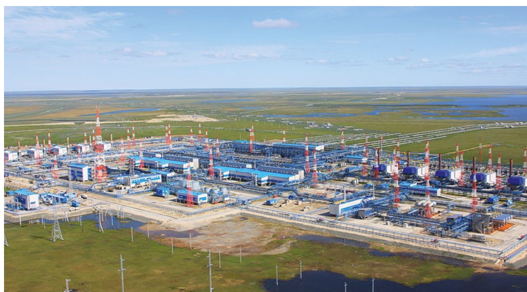
Установка комплексной подготовки газа и дожимная станция ГП-3
