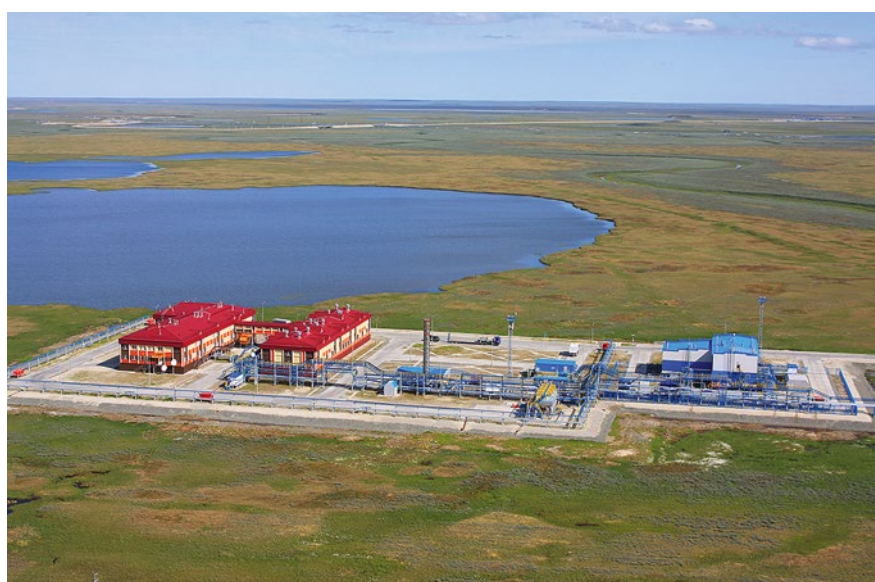
Вахтовый жилой комплекс ГП-3
