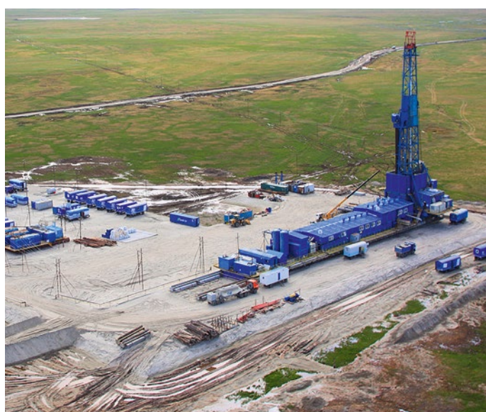
Бурение на Харасавэйском газоконденсатном месторождении
