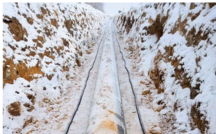
Межпоселковый газопровод от ПРГ «Ботанический сад» до ГРС «Южная»
