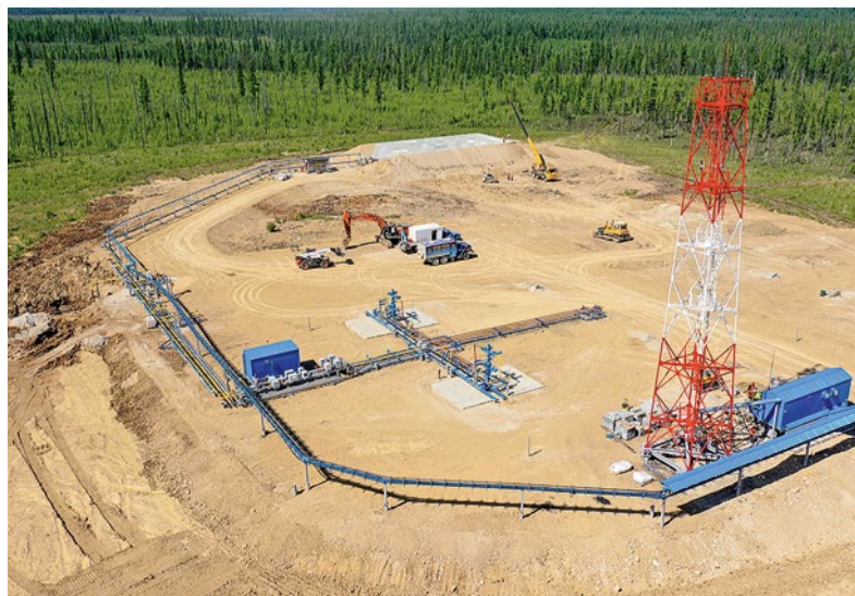
Обустройство Чаяндинского НКГМ. Куст газовых скважин № 44
