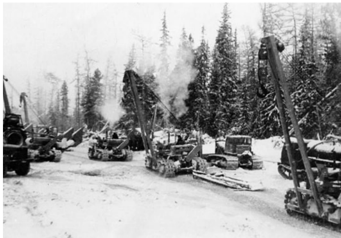
Строительство газопровода «Саратов-Москва» в зимний период.
