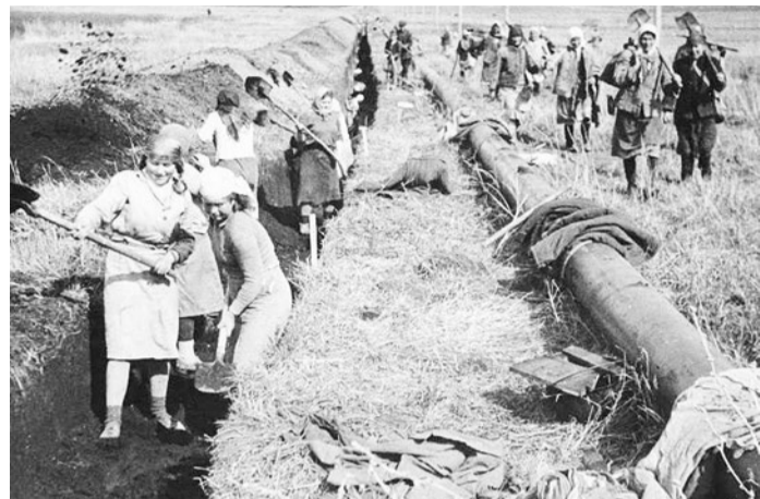
Комсомольская бригада М. Лушиной из колхоза им. Сталина на строительстве газопровода «Саратов-Москва». 1945 г.
