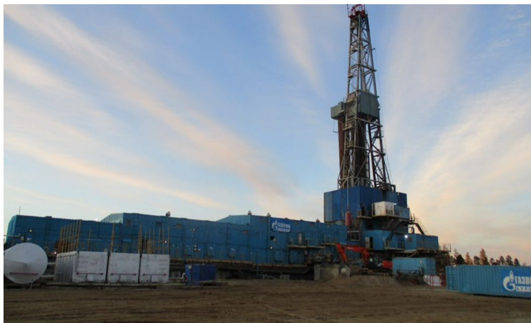
Буровая установка на КТС № 83 № 2039 Чаяндинского НГКМ
