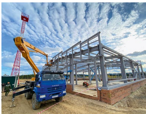
Монтаж металлоконструкций пожарного депо
