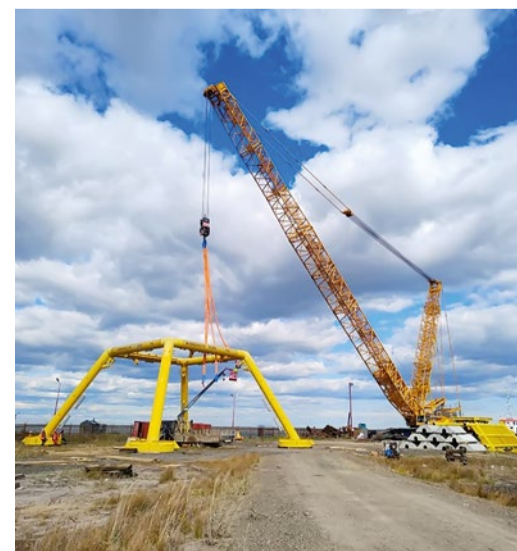
Подготовка к погрузке защитной конструкции подводной фонтанной арматуры
