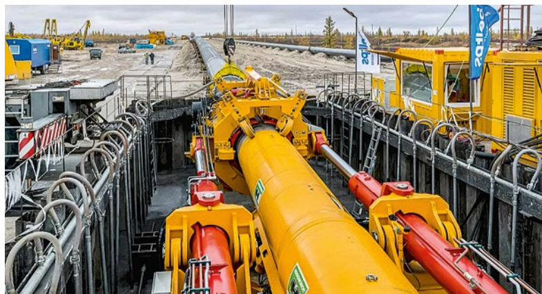
Монтаж доталкивателя подводного трубопровода
