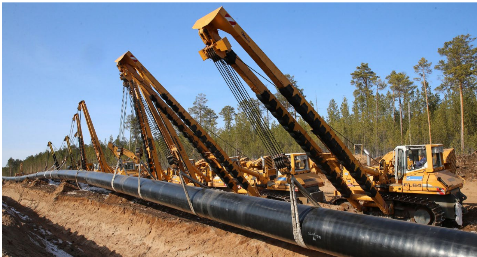
Строительство газопровода «Сила Сибири»
