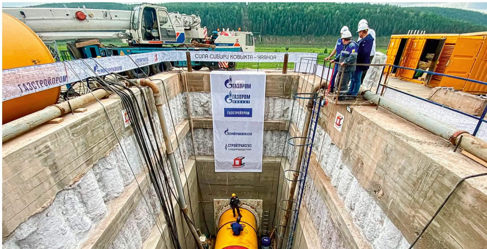
Магистральный газопровод «Сила Сибири». Устройство перехода через р. Лена
