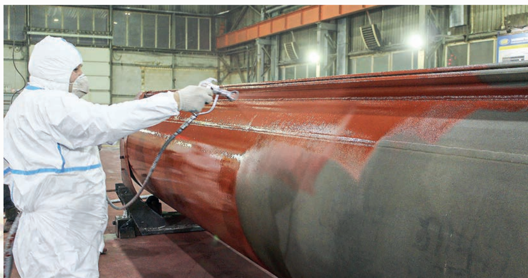
Нанесение защитного покрытия «Базалит — М» на ответственные конструкции причального комплекса
