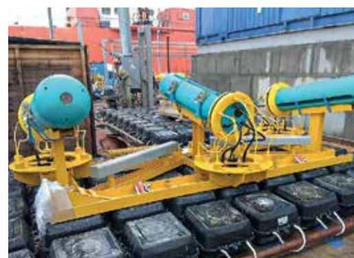
Аноды, подготовленные для погружения на морское дно на объекте «Терминал по приему, хранению и регазификации сжиженного природного газа в Калининградской области»
