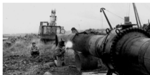
Строительство магистрального газопровода «Кохтла-Ярве — Ленинград»
