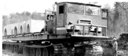
Строительство магистрального газопровода «Серпухов — Ленинград»
