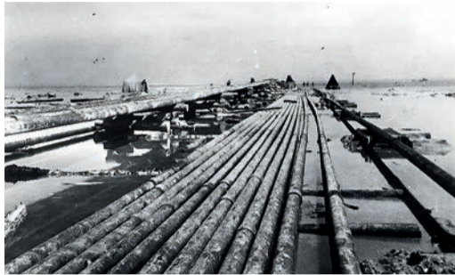
Строительство трубопровода по дну Ладожского озера. Фото из архива Государственного музея обороны и блокады Ленинграда
