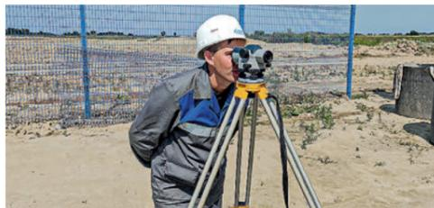
Оптический нивелир (проверка высотного положения планировки площадки)
