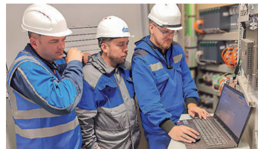
Контроль параметров ГПА при проведении горячего запуска на УКПГ-3С Заполярного НГКМ
