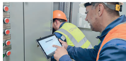
Наладка силового оборудования на КС «Воркутинская»
