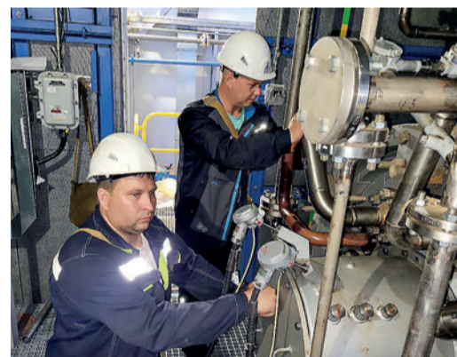
Подготовка к подаче буферного газа на ГПА ДКС-1, 2 Оренбургского НГКМ
