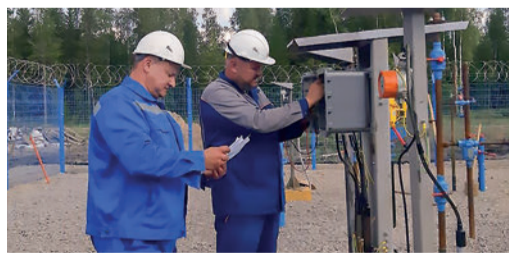
Наладка передачи данных положения крана
